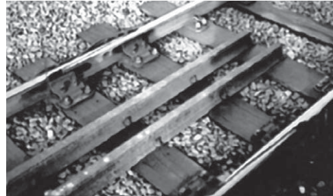
Gambar 6.6 Rel kereta api dibuat renggang untuk tempat pemuaian karena kenaikan suhu di siang hari.
